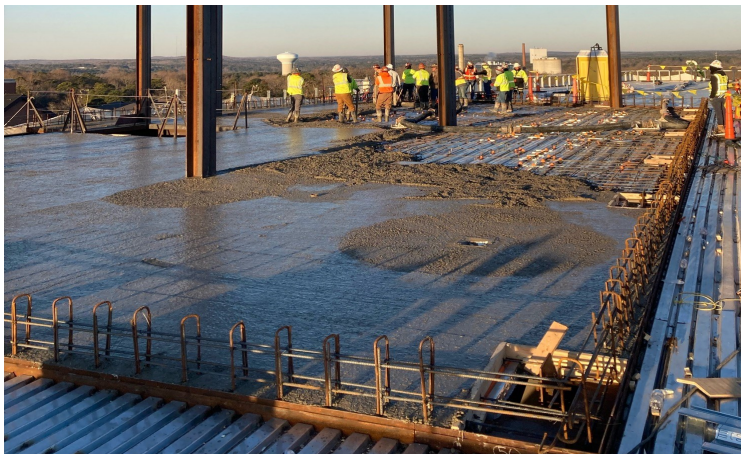
Final Concrete Slab Pour at Level 9
